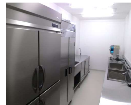
左手前:業務用冷蔵庫 右隣:消毒保管機
