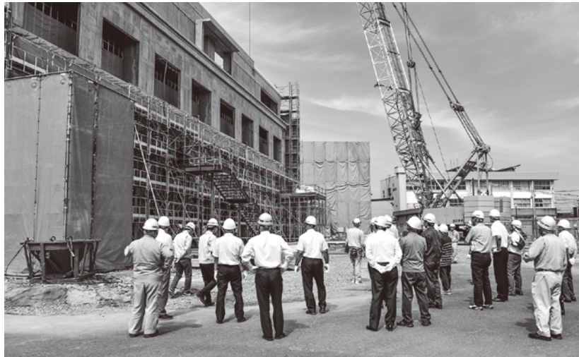
できるところは地元業者で 新庁舎工事現場
