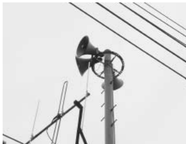
▲ただ今、〇〇地内で火災発生
