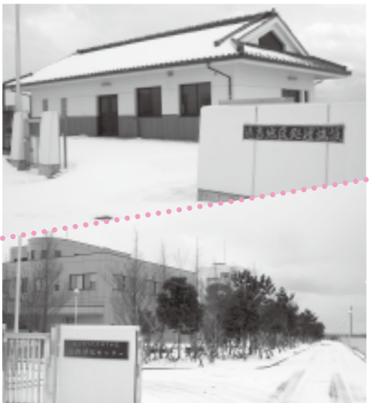
▲料金統一はいつ？（それぞれの処理施設）
