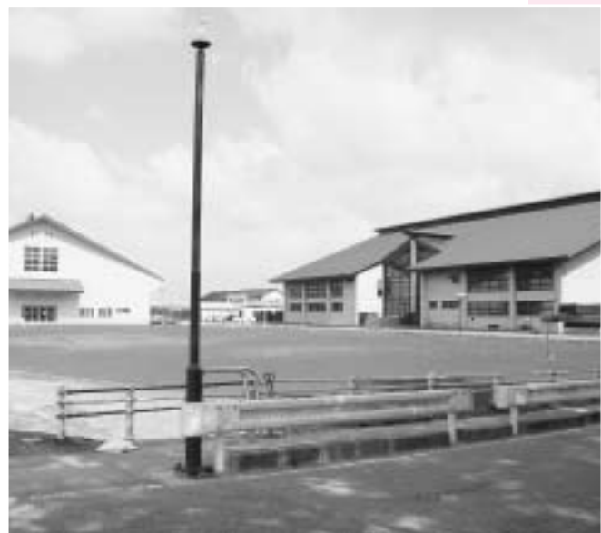
▲着工まれる八幡スポーツ公園
