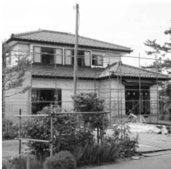
▲夢のマイホーム、完成間近
