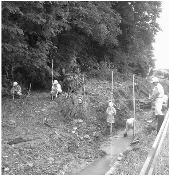
▲復旧作業は、急ピッチで
