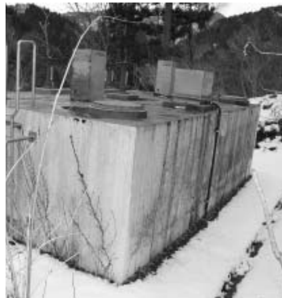
▲山の上の貯水池(立谷沢地域の簡易水道)
