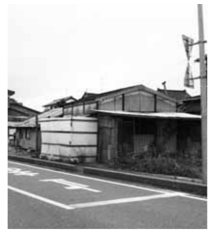
早く解体を（旧・作業所 興野）
