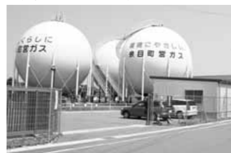
町営ガスタンク
