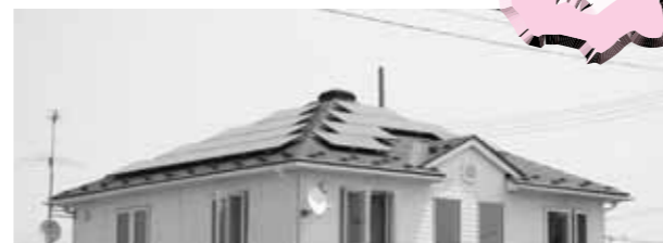
屋根の上でソーラー発電
