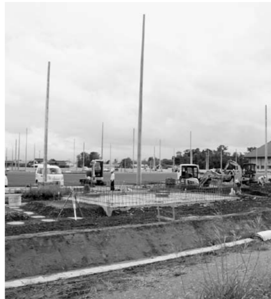
工事が進む八幡スポーツ公園
