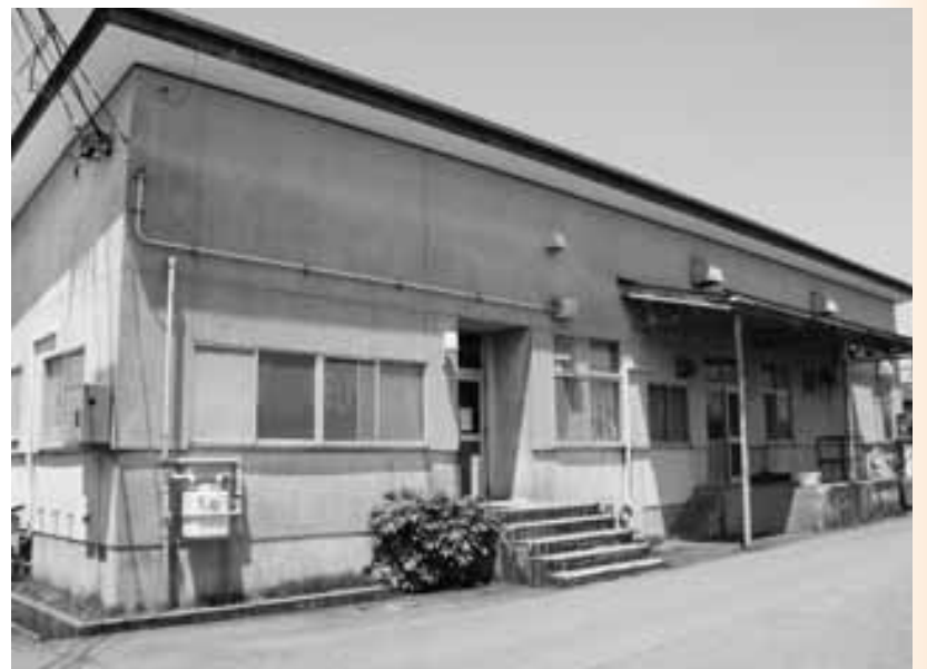
改築が望まれる学校給食共同調理場
