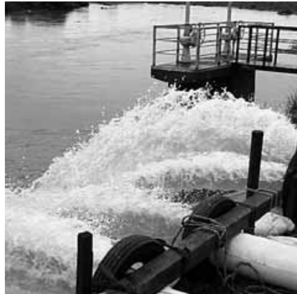
ポンプ車による京田川への放水作業（平成25年8月）
