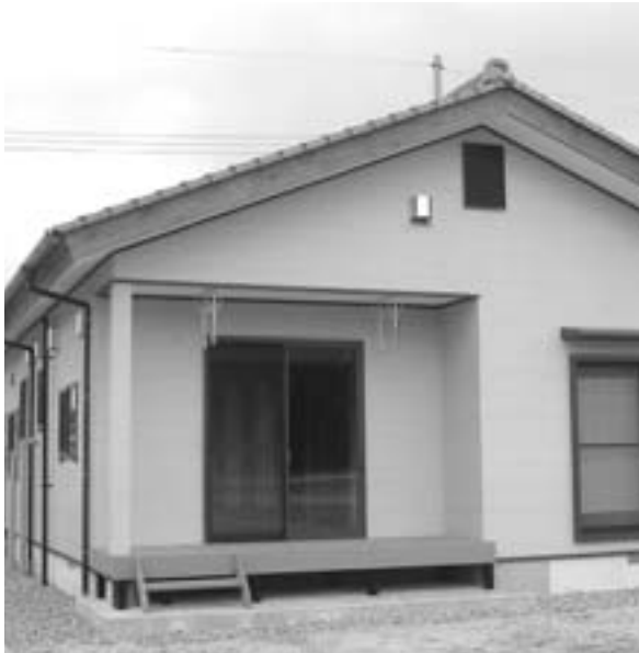
3月に2戸完成した山居住宅
