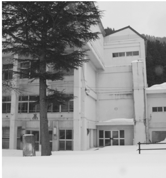
もったいない、倉庫で活用（旧立谷沢小学校）
