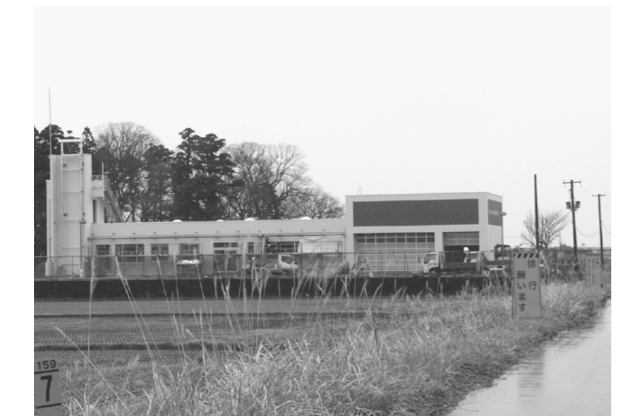
消防署立川分署 着々と建設中
