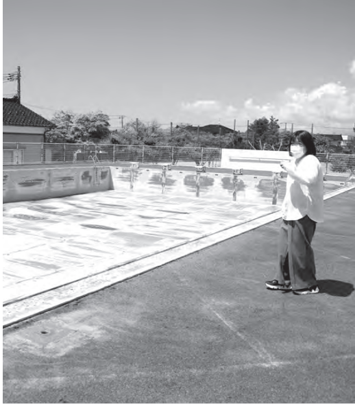
消火のための水はなし 余目中学校
