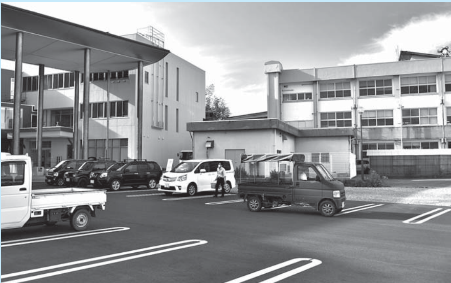
旧庁舎解体 駐車場増設
