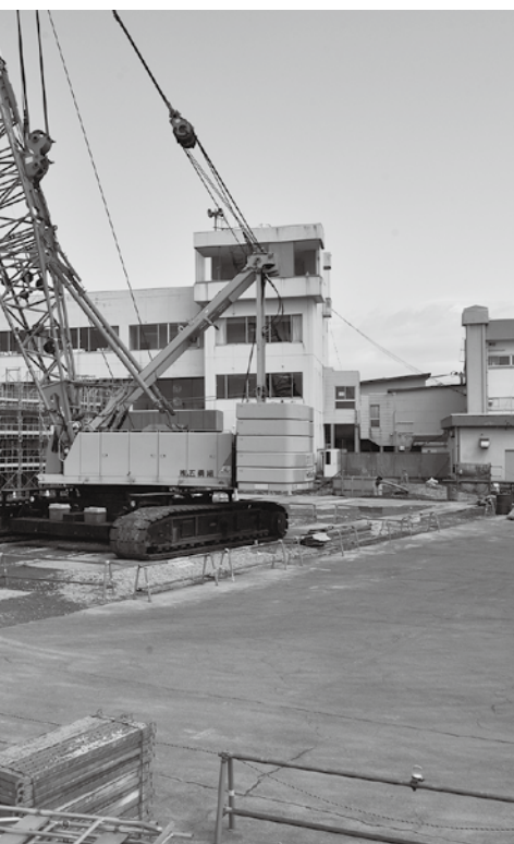
新庁舎工事現場
