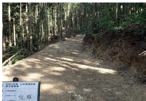
三ヶ沢団地 作業道
