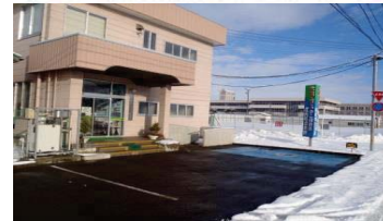
↑↑企業課庁舎駐車場もロードヒーティングを使用しています
