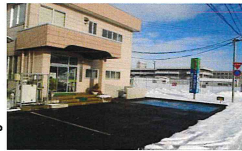
↑企業課庁舎駐車場もロードヒーティングを使用しています
