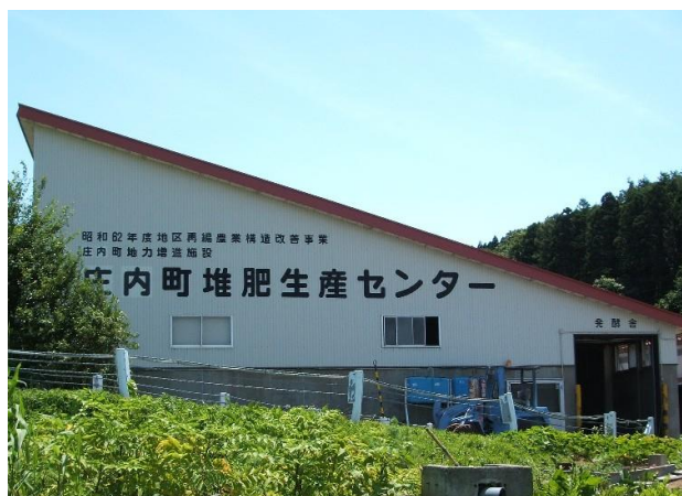
庄内町堆肥生産センター「エコリンク」
